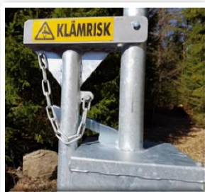
Lyftbom, klar för stängning i upplåst läge.
